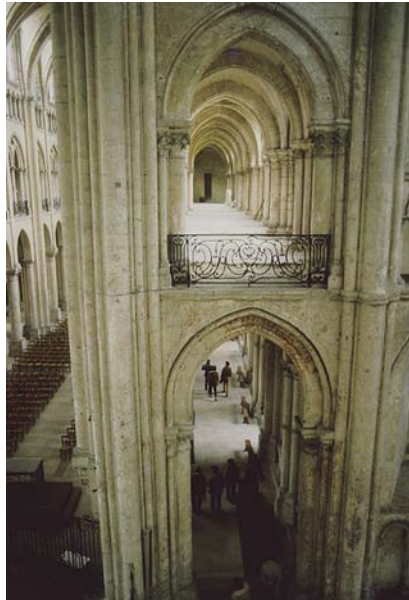
Voûte sextpartite, alternant pile forte et pile faible
