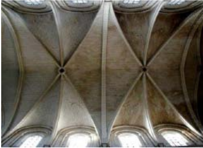
Voûte sextpartite, alternant pile forte et pile faible
