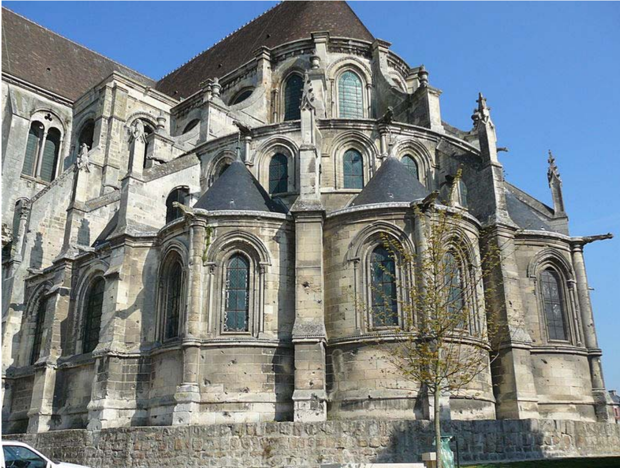
Les absidioles et les contreforts
