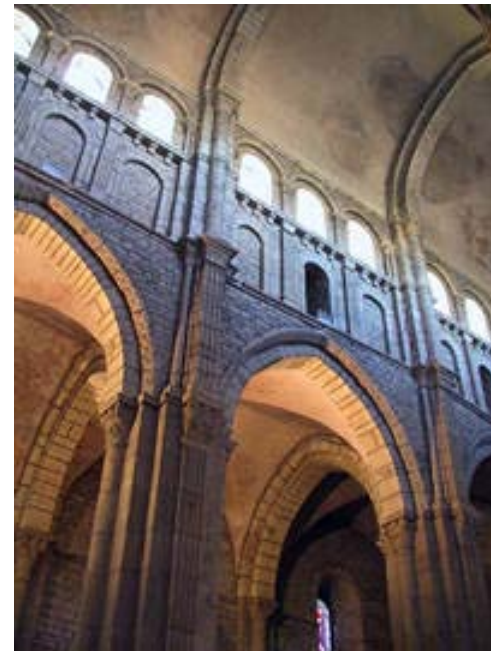
Voûte en berceau de la nef centrale
